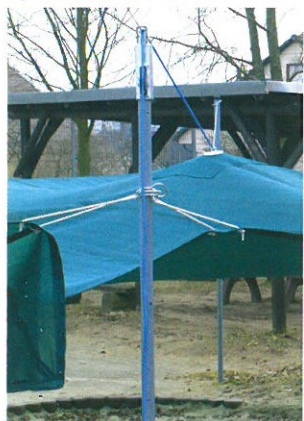
Beispiel eines Mittenaufzuges, Pfosten Ø 48mm
